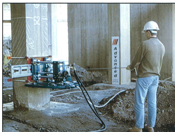
Dispositivo da applicare ai pilastri per il taglio dello stesso.
